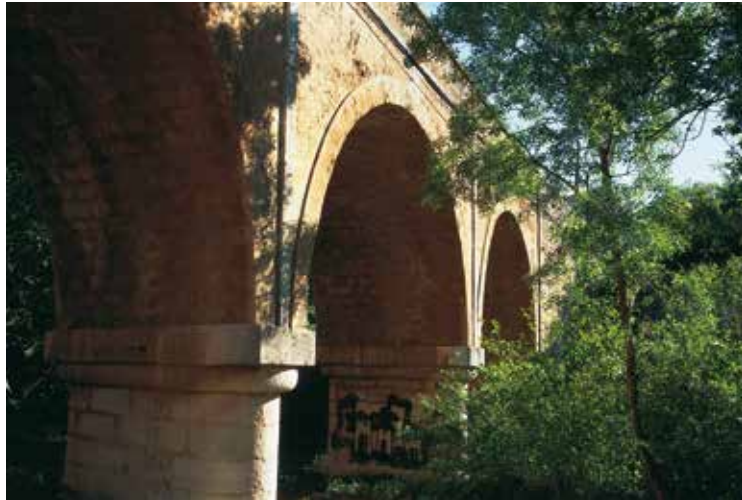
La pedra del pont Vell fou tallada a la serra de la fusteria de Prades, el seu constructor
